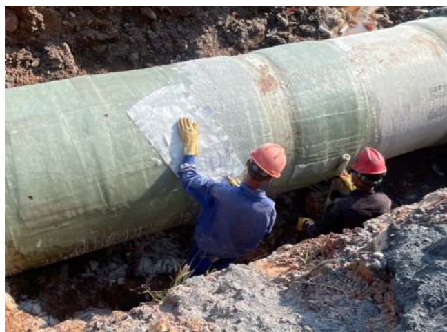
现场管道修复
